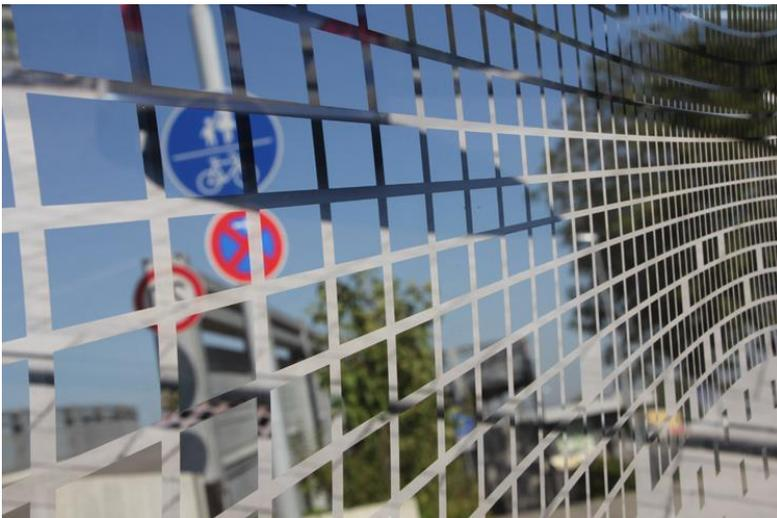
*Abbildung 1: Flachglas mit Sputterbeschichtung*
